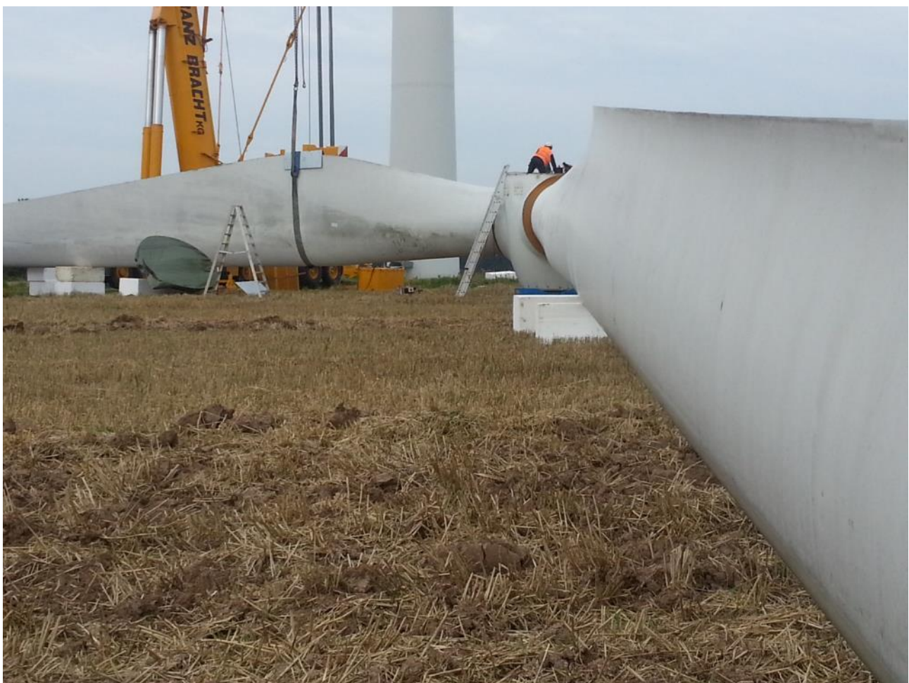
Abbildung 3: Demontage des Rotorsterns am Boden
